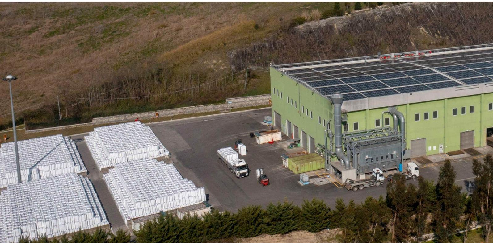
Figura 37 - Impianto Fotovoltaico sulla copertura del TMB Fonte: repertorio Deco S.p.A.
