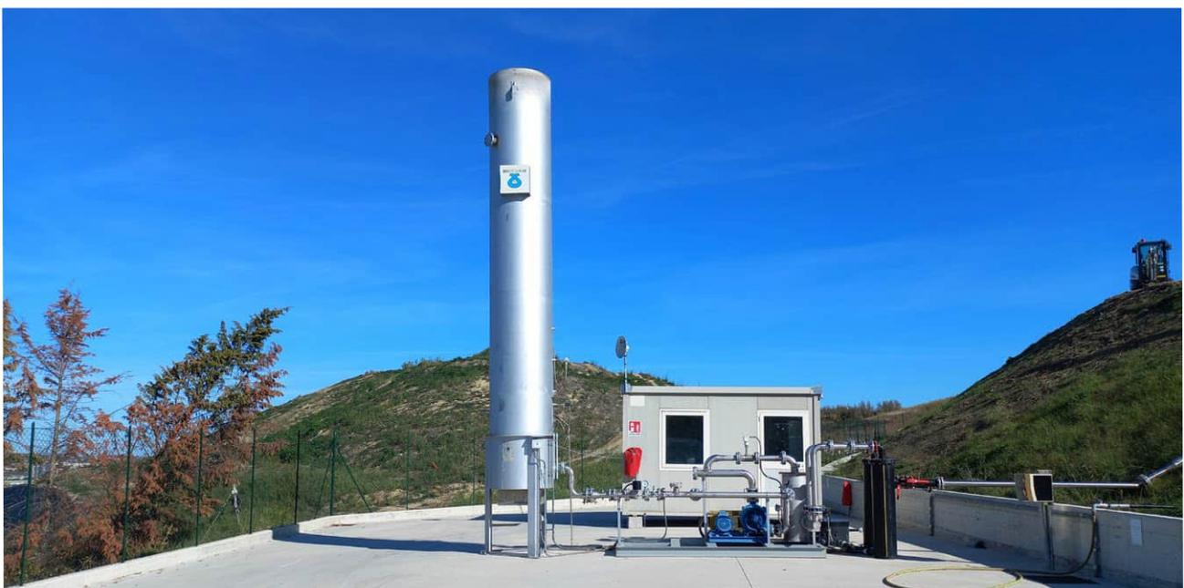
Figura 28 - Discarica Grasciano2 - Torcia di combustione Fonte: repertorio Deco S.p.A.
