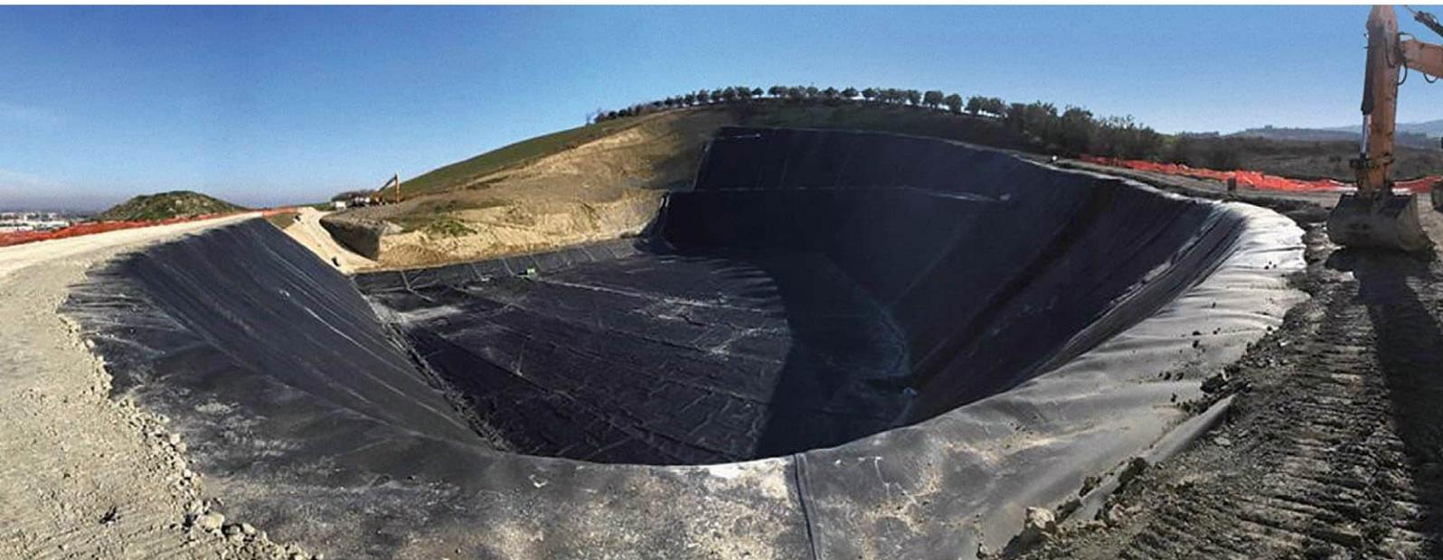
Figura 30 - Discarica Grasciano2 in fase di realizzazione Fonte: repertorio Deco S.p.A.
